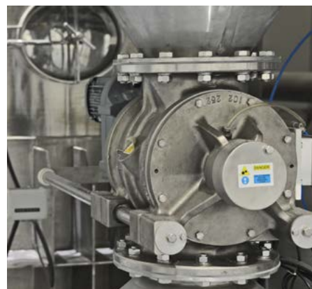
Écluse rotative pour extraction
