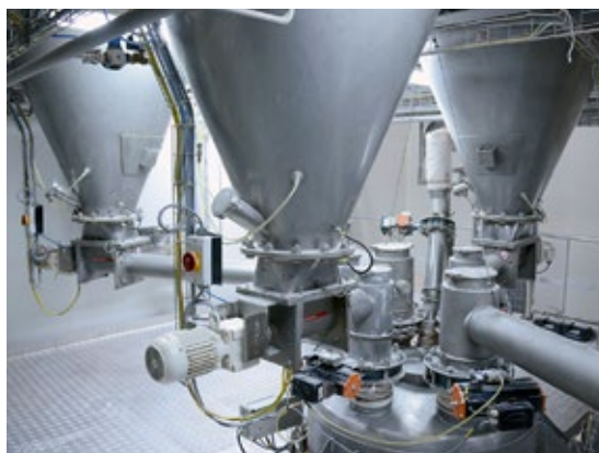
直接投料至反应罐
